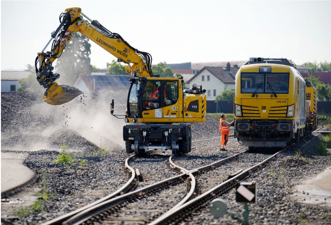
Rückblick: Arbeiten auf der Riedbahn im Sommer 2024
